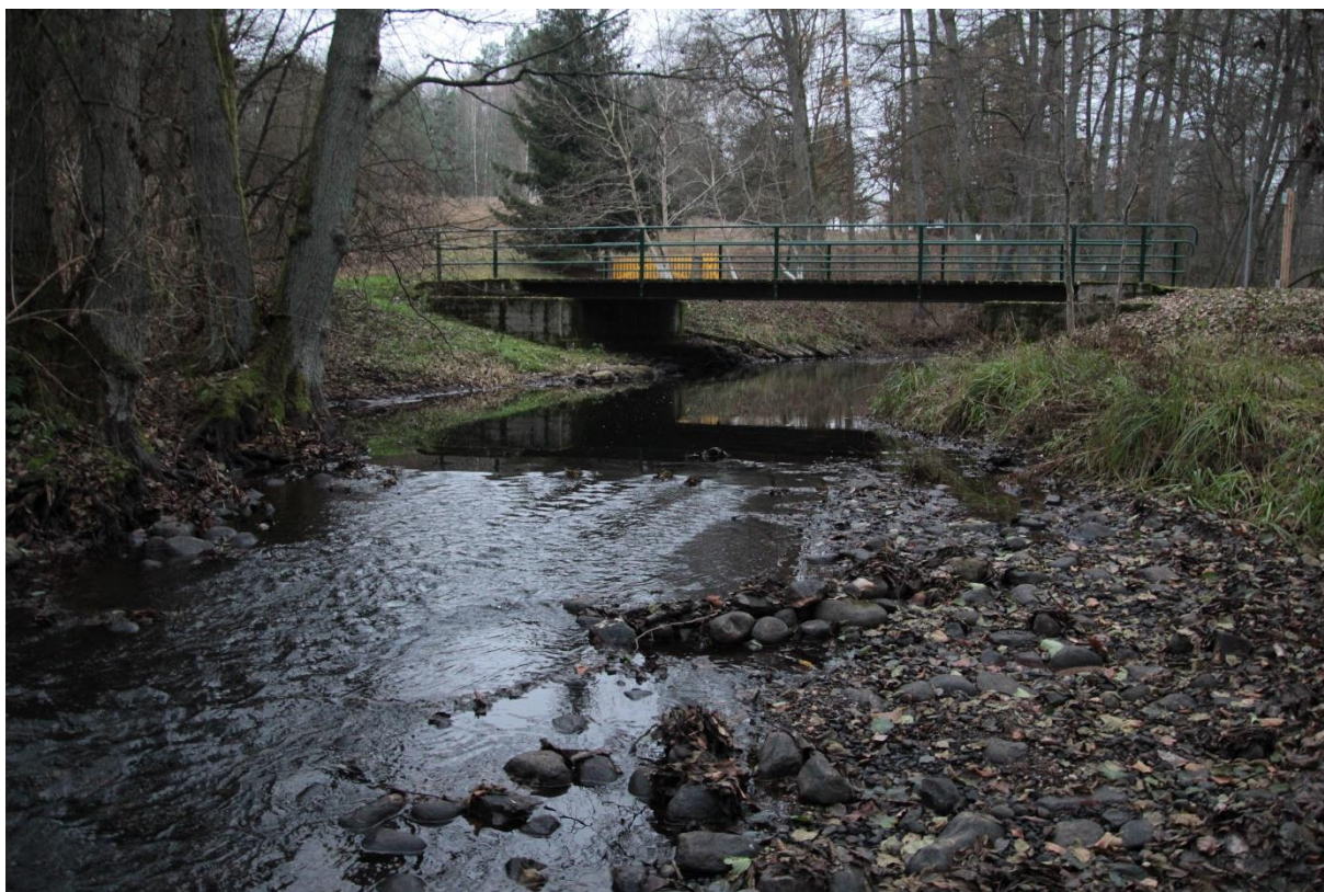
Fot. 2 Okolice Głębozka, korona pryzmy stabilizującej wodę na tym odcinku.
