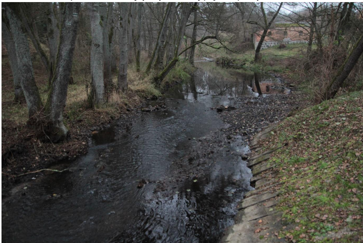
Fot. 3 Okolice Głębozka poniżej ruin jazu. Wyraźnie widoczny efekt wykonania sekwencji bystrzy stabilizujących poziom niskiej wody na odcinku w dół od jazu.
