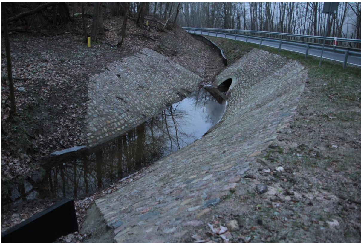
Fot. 2 Odnowiony przepust pod drogą 163 w biegu źródłowym Drawy. Dno rzeki zostało pogłębione, tak w ciągu przepustu, jak i powyżej niego. Tego typu działania wpływają negatywnie na stan wód gruntowych, a co za tym idzie, na stan ekologiczny Drawy.
